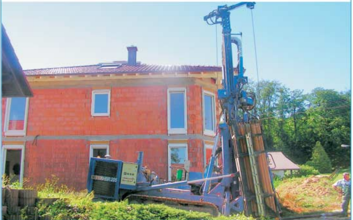
Drill rig type HBR 205 GT.
