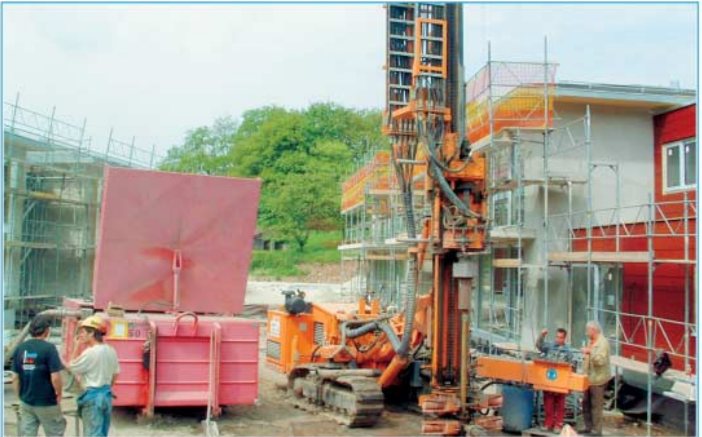
Drill rig type HBR 605.
